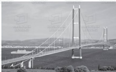
1915 Çanakkale Köprüsü de Yap-İşlet-Devret modelinde yapıldı.
