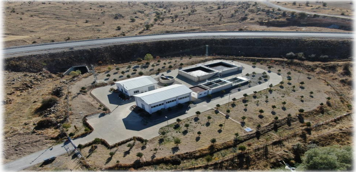
Melikgazi Gürpınar Atıksu Arıtma Tesisi
