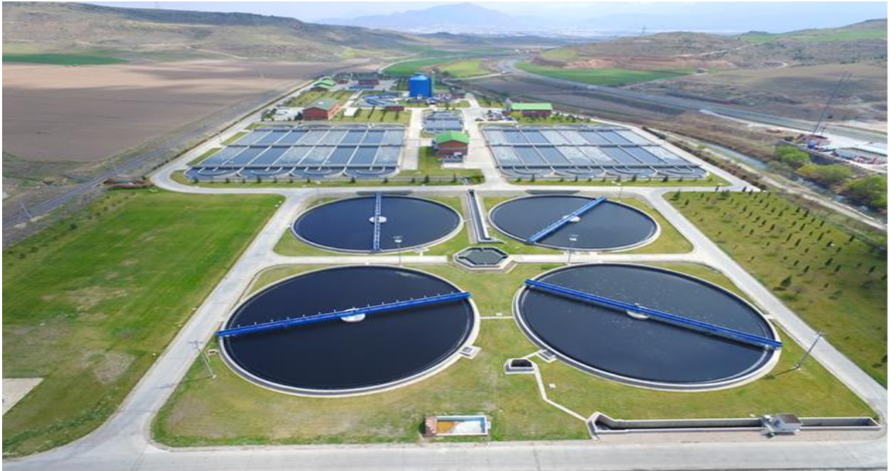
Kayseri İleri Biyolojik Atıksu Arıtma Tesisi
