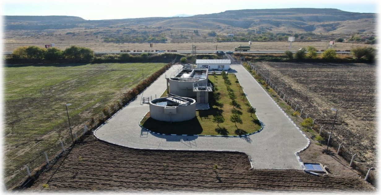
İncesu Süksün Atıksu Arıtma Tesisi
