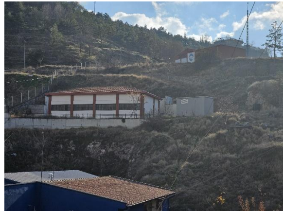
Mevcut Su Deposu
