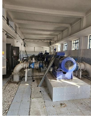
Mevcut Su Pompalama İstasyonu
